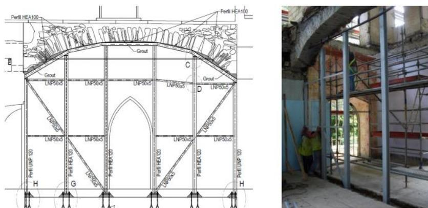
Figura 43 - Reforço da estrutura sob os arcos em alvenaria (Imagens da PSML e CivilSer)
